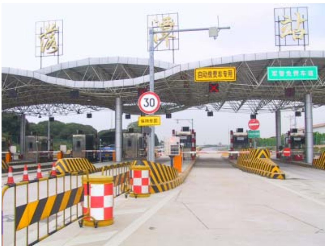
图 6-1 钟落潭站 ETC 车道
